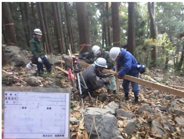
かご枠工 丁張り作業 ( 令和 2 年 12 月 相模原市緑区三井 地内 )
