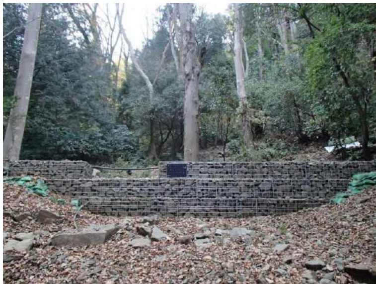
山腹基礎工、かご柵工 ( 相模原市緑区三井 地内 )
