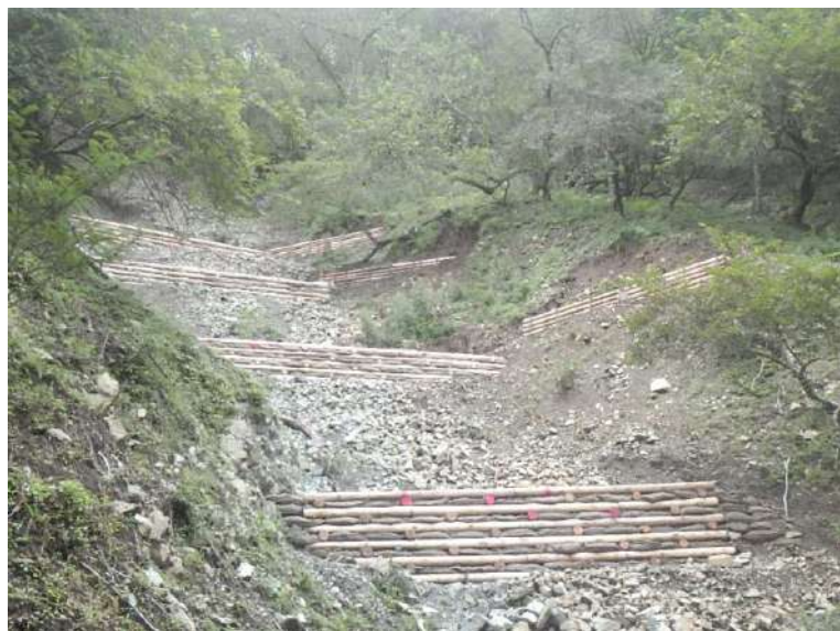
土壤保全工、丸太積工 ( 山北町玄倉 地内 )
