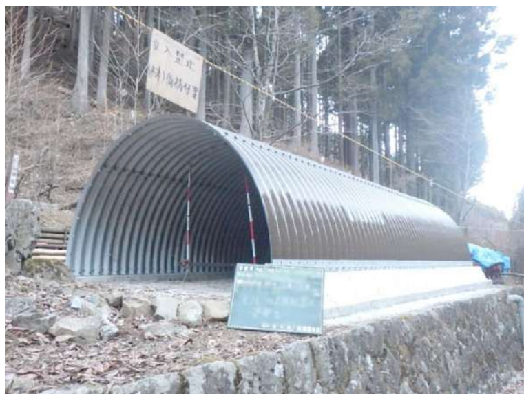
モノレール格納庫 ( 清川村煤ヶ谷 地内 )
