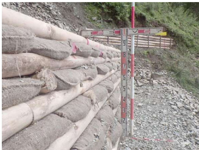
丸太積工 ( 土壤保全工 )
