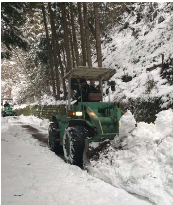
林道・作業道などの除雪作業
