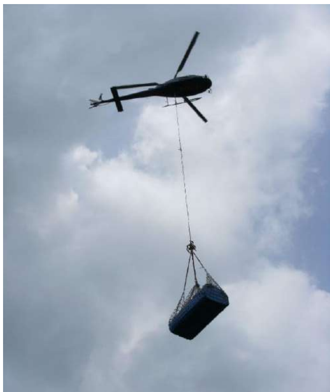
高い山にはヘリコプターで資材を運 足柄上郡山北町中川 地内
