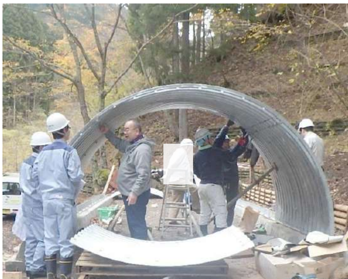
山林用モノレール格納庫 建設中 清川村煤ヶ谷 地内
