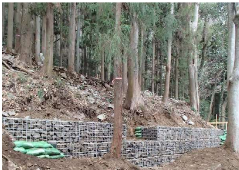
山腹基礎工（かご枠工） 相模原市緑区三井 地内
