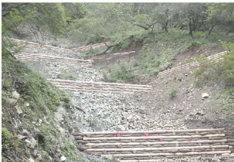
土壤保全工（丸太積工） 山北町玄倉 地内
