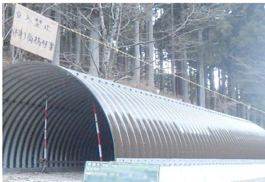
モノレール格納庫 清川村煤ヶ谷 地内
