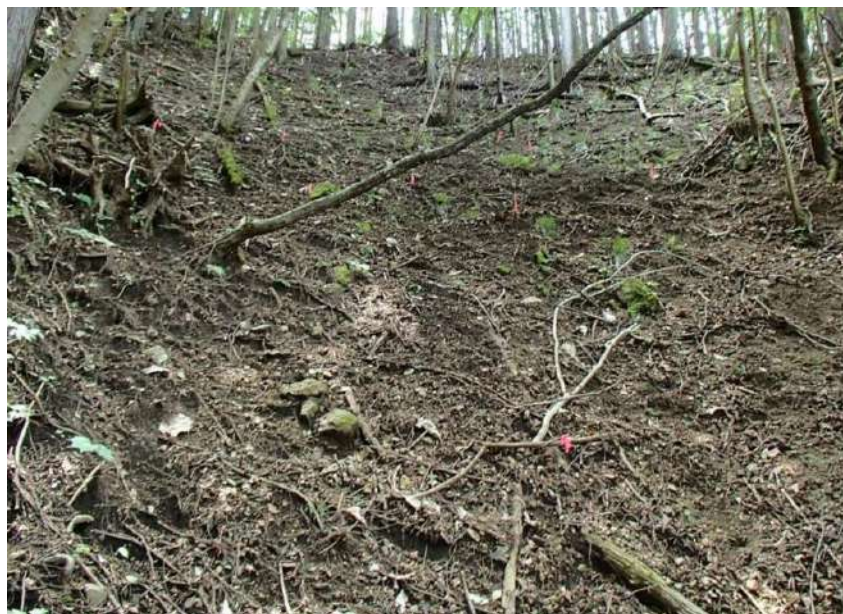
丸太筋工 施工前 相模原市綱子 地内 崩落が続き、下層植生の生育ができていません。
