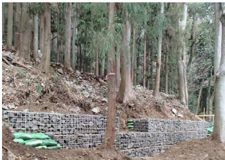
山腹基礎工 かご砕工 相模原市緑区三井 地内
