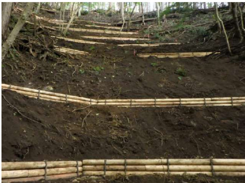
丸太筋工 施工後 相模原市綱子 地内 表土の移動を防ぎ、雑草木の発生や生育を促します。
