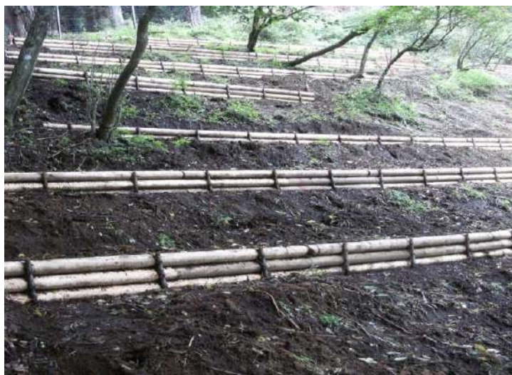
土壤保全工 丸太筋工 山北町玄倉 地内
