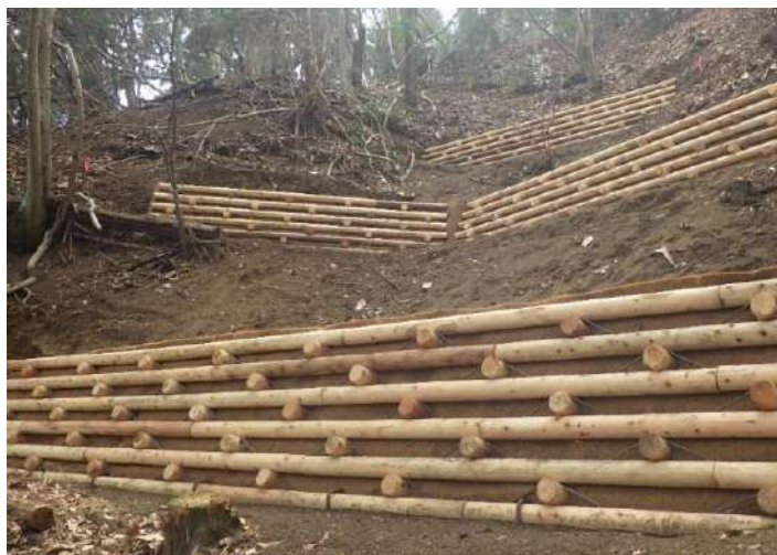
丸太積工 施工後 相模原市緑区青山 地内 法面を安定させ、雑草木の発生を促します。
