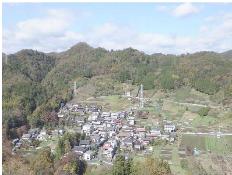
株式会社高橋林業 遠景 相模原市緑区牧野 地内
