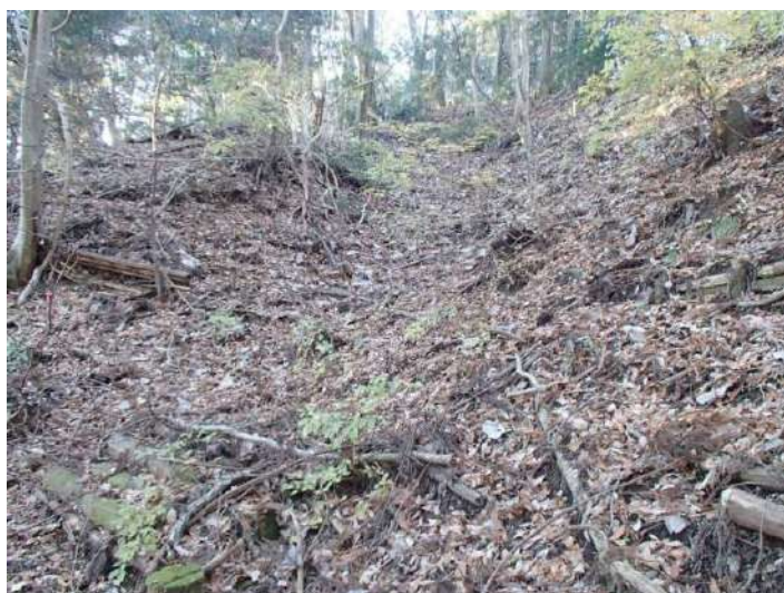
丸太積工 施工前 相模原市緑区青山 地内 法面崩壊地の土砂の崩落が続いています。
