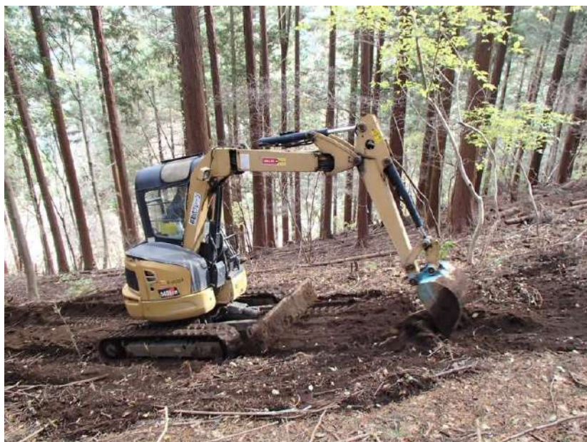
作業路 新設工相模原市緑区三ヶ木 地内
